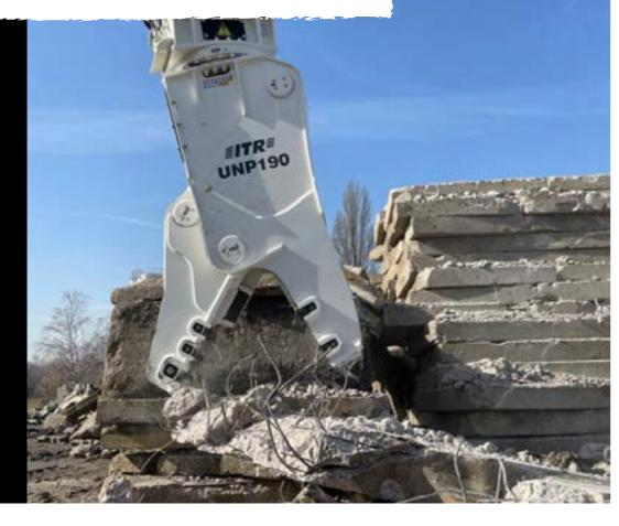
DREHBARE PULVERISIERER: Ideal zur Zerkleinerung und Trennung von Abbruchmaterial. Die drehbaren Pulverisierer von ITR bestehen sind aus verschleißfestem HARDOX® 400 gefertigt. Sie sind mit einem Regenerationskreislauf zum schnellen Öffnen und Schließen der Backen ausgestattet. Darüber hinaus ermöglicht die hydraulische Drehung um 360° eine genaue Positionierung des Pulverisierers bei allen Arbeitsbedingungen.
