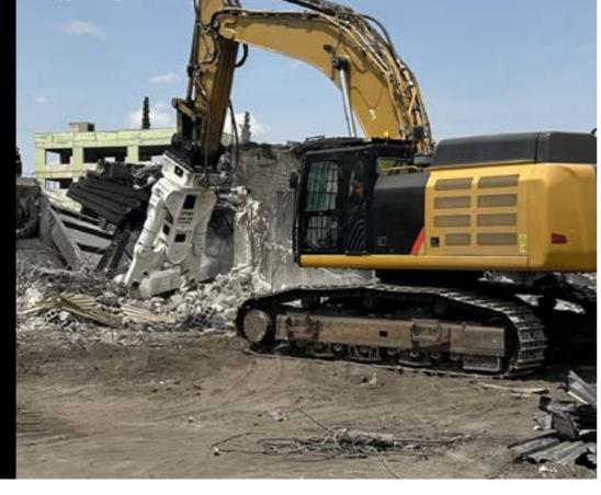
Die ITR Multikit Abbruchzangen zeichnen sich durch eine perfekte Symbiose aus Funktionalität und Vielseitigkeit aus. Die breite Auswahl an verfügbaren Kits ermöglicht es mit den UNM-Serien, sämtliche Anforderungen in jeder Phase von Abbrucharbeiten umfassend zu erfüllen. Mit ihrer robusten Struktur aus besten Stahlsorten stehen diese Abbruchzangen für höchste Belastbarkeit und Langlebigkeit und bieten somit eine zuverlässige Lösung für unterschiedlichste Einsatzszenarien im Abbruchbereich.
